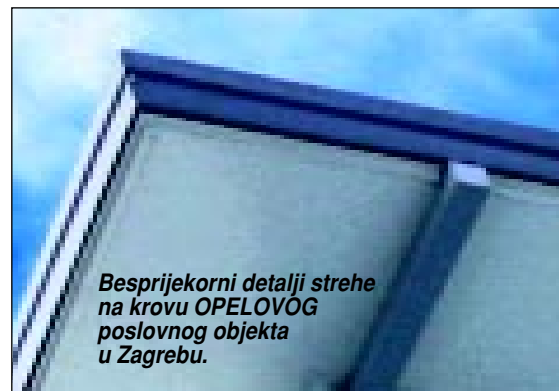
Elastična i plastična svojstva SINTOFOILA najbolje dolaze do izražaja u finom oblikovanju detalja na opšavima i okapnicama.
